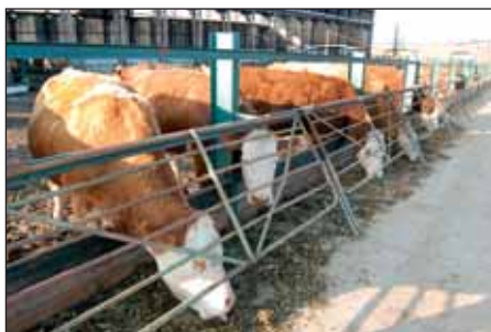
Preventívne technické opatrenie proti úniku teliat z kotercov.
